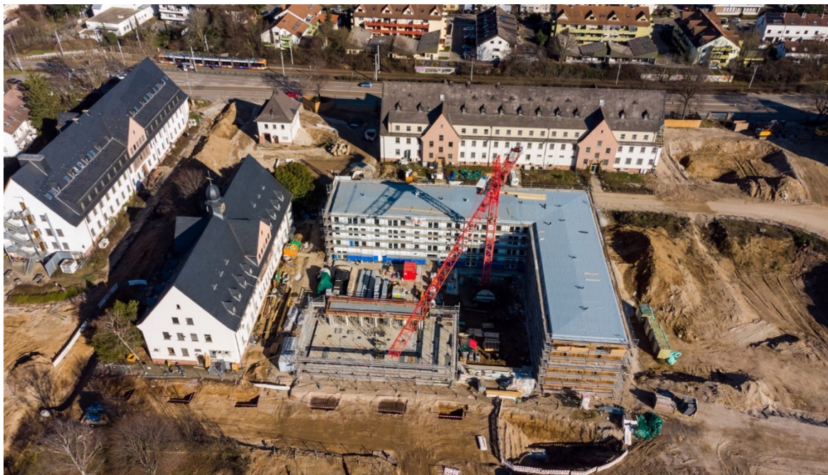
Abbildung 2 - Die Baustelle im März 2021 von oben [Bildquelle: Ulli Hillenbrand]
